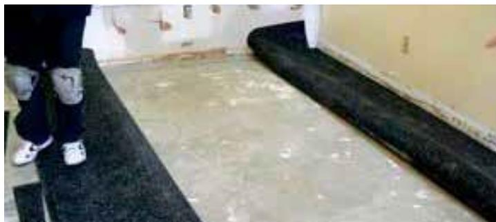
**1.** Для нанесения связующего отогните первую полосу на 0,6 м вдоль от стены по всей длине. Не допускайте нагрузки на гиб рулона.
